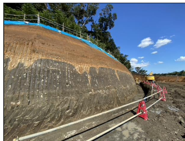
横浜国大付近の工事現場に現れた地層
