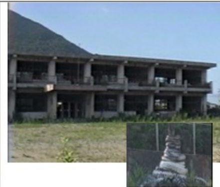
火砕流で破壊された 島原市旧大野木小学校
