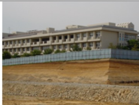
火山灰で高まった土地に建つ 横浜市立都築小学校
